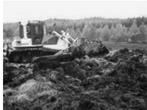
写真-7 レーキドーザによる排礫
