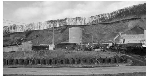
浄水施設の復旧工事状況
