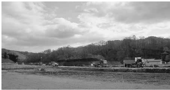
土砂運搬状況
